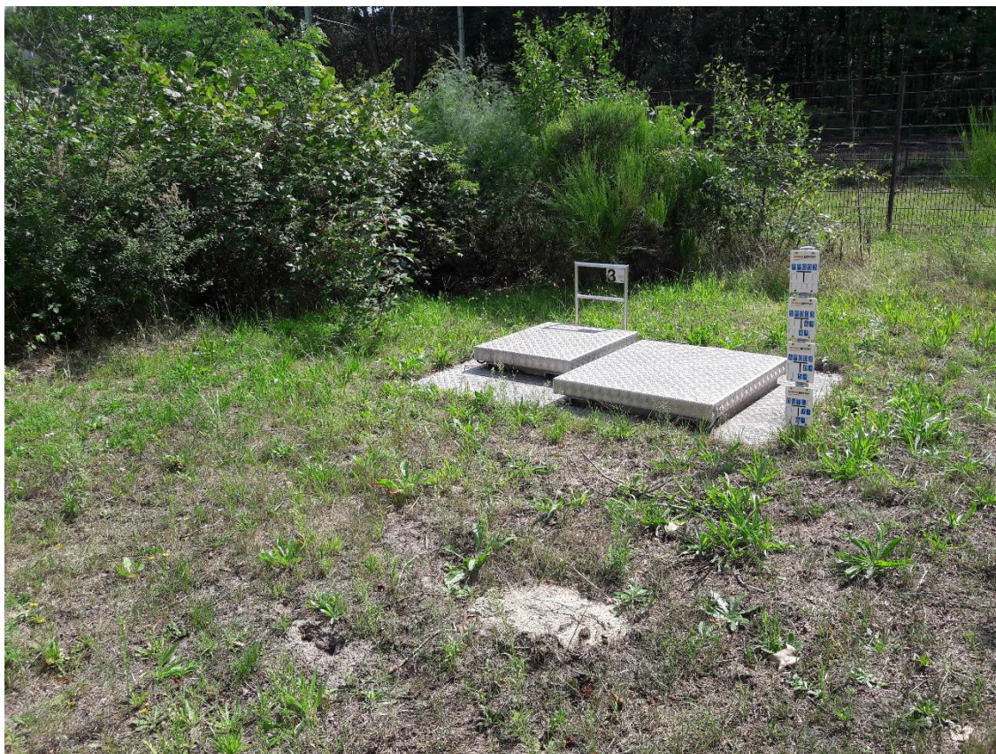
Figuur 6: Grondwaterwinput op de bestaande winlocatie Seppe
