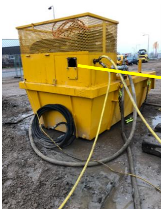
Vulling doormiddel van vlotter pomp
