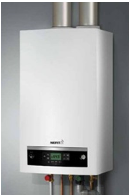
Voorbeeld van een combiketel. Links het overstortventiel (rode knop) en rechts de inlaatcombinatie (groene knop)
